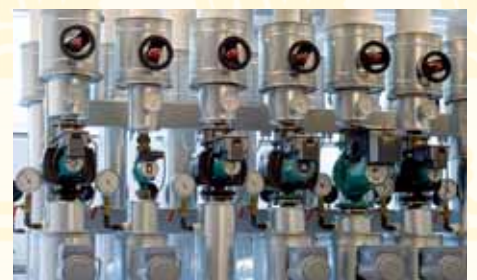
Der Wärme-Service arbeitet mit modernster Technik
